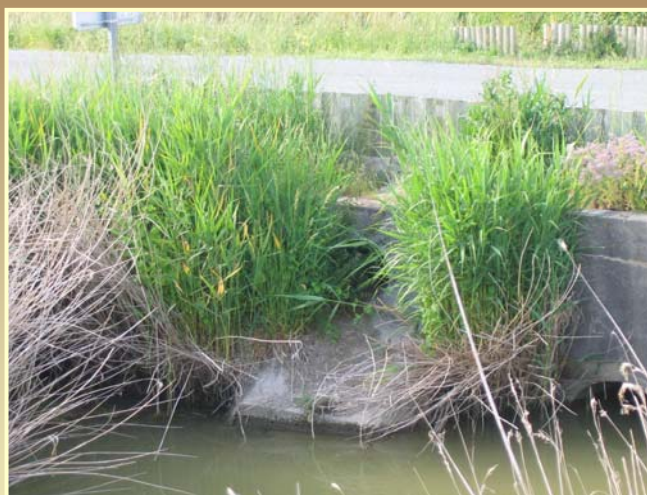
Passage à Loutre, réalisé en 1992 par le Parc Naturel Régional du Marais Poitevin, l'association Pro Lutra et l'ADEV, en bordure de la Réserve Naturelle de Saint Denis du Payré.
