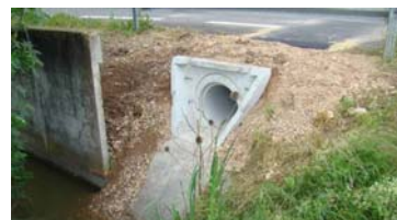
Passage à loutre aménagé sous la RD 747 au lieu-dit Le Grand Pré – Commune d'Angles
